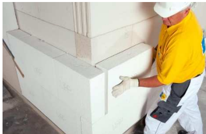
> Kalksandsteinwand + Wärmedämm- verbundsys- tem (WDVS)
