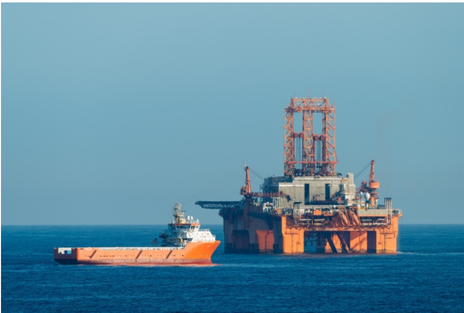
Abb.11: Ölbohrinsel West Phoenix in der Nordsee mit Versorgungsschiff (© imageBROKER.com / Olaf Krüger)
