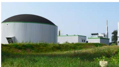
In Vergärungsanlagen wie dieser wird aus Bioabfall Energie in Form von Biogas gewonnen.
