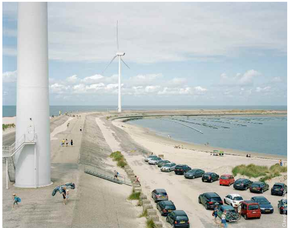
Oosterscheldedamm in Holland: Um ihn zu bauen wurde die künstliche Insel Neeltje Jans aufgeschüttet.
