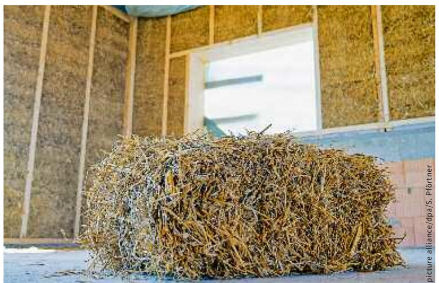
Stroh wird bei uns meist in nichttragenden Konstruktionen verbaut. Das Gewicht von Dach und Obergeschoss fängt ein Holzständerwerk ab.
