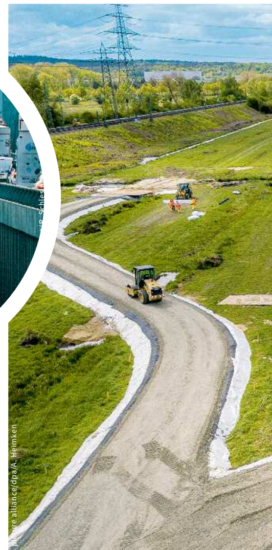
Blick von oben auf die bereits im Bau befindliche Trasse der A26 West, die von Niedersachsen nach Hamburg führt.
