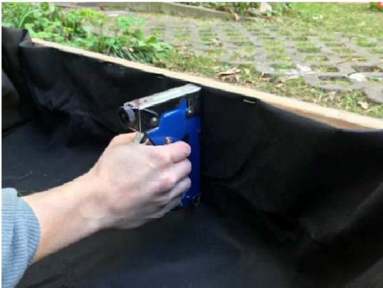
Abbildung 2: möglichst dichtes Setzen der Tackernadeln minimiert den Zug auf einzelne Nadeln
